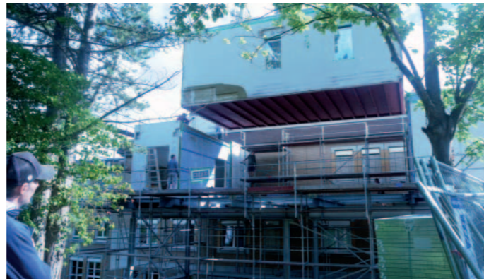
Millimeterarbeit: Mit einem Schwerlastkran heben Arbeiter das letzte Modul des neuen OP-Saals auf dessen stählernes Tragwerk.
